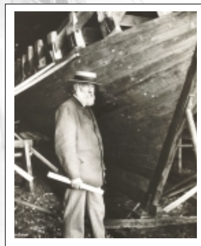
Kravellbygde skrog (kjennetegnet av slett, jevn hud) var en av Colins kjepphester. Utvendig jernkjøl (kjølen hadde et metallstykke innfelt) var en annen. (Foto: Redningssselskapets arkiv)
